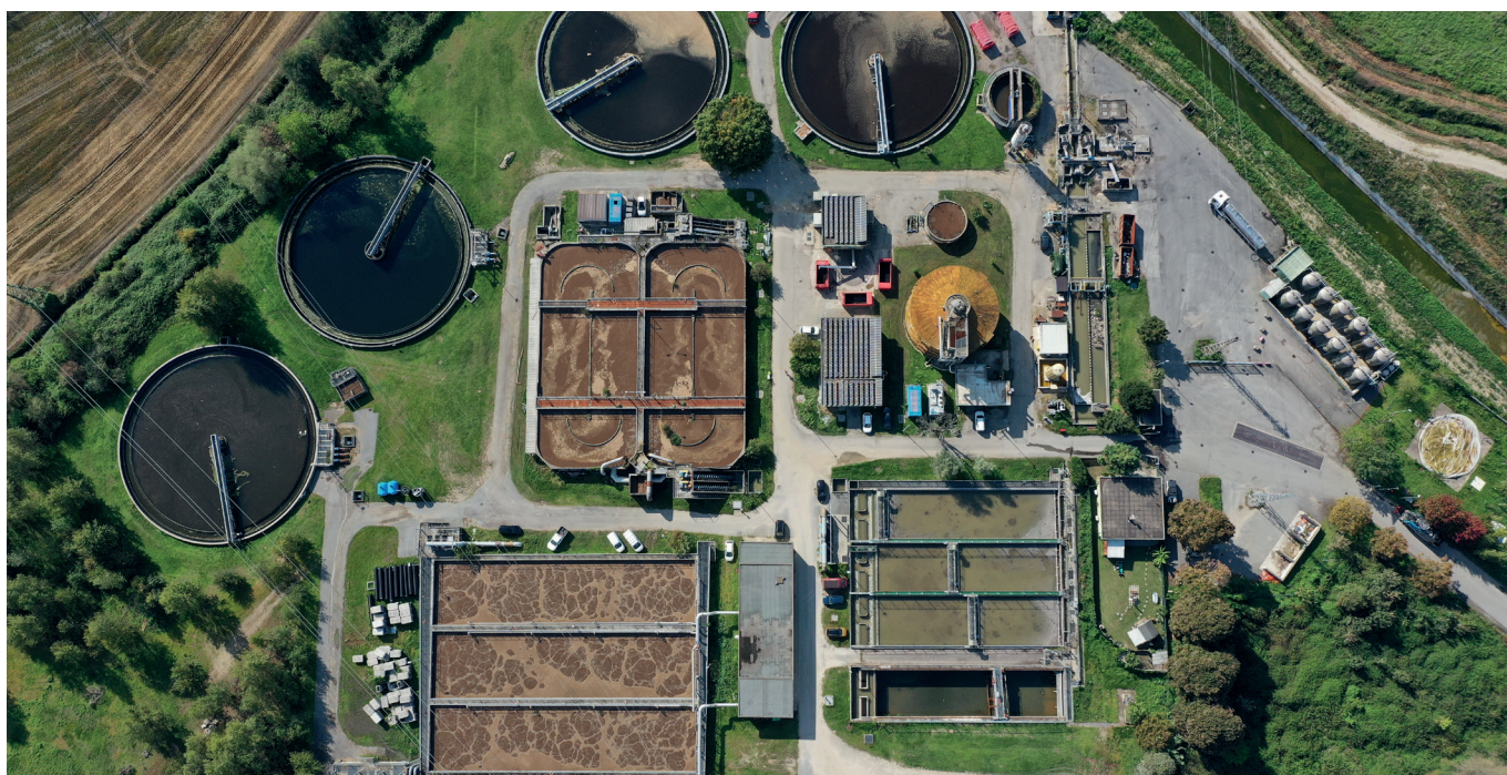
Impianto di depurazione di Novara
