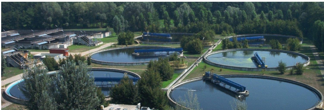
FIGURA 5 | IMPIANTO DI DEPURAZIONE
